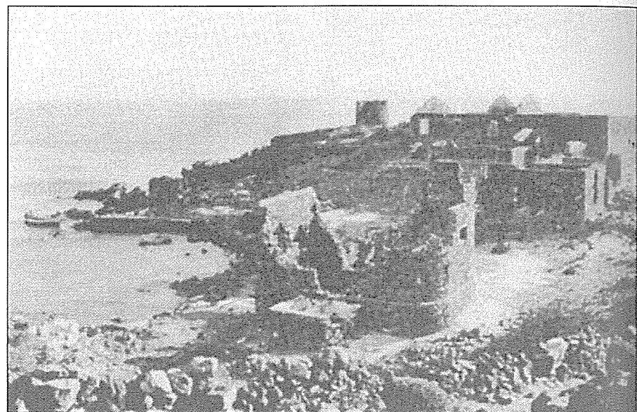
Τὰ ἐν «Ἁγία Εἰρήνη» εἰρείπια τῶν ἐργοστασίων Ἰ. Ἀλεξ. Ράλλη, 1879, ἐγκατασταθέντων διὰ τὴν κατασύντριψιν καὶ ἐκκαθάρισιν τῆς θειούχου ὕλης.
