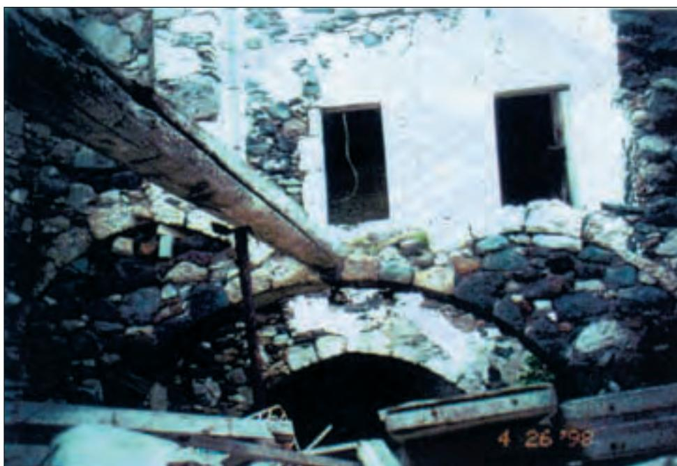
**Φωτ. 30.** Χαρακτηριστικό παράδειγμα «σύνθετου, τοξωτού, διαχωριστικού στοιχείου»
