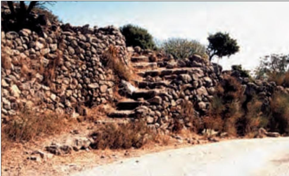
**Εικ. 18:** Αξιοθαύμαστο παράδειγμα βαθμιδωτού μονοπατιού, που αναπτύσσεται υπό γωνία, ακολουθώντας τη φυσική κλίση του εδάφους. Η γοητεία της κατασκευαστικής τελειότητας, μέσα από ένα πάντρεμα υλικού, κλίμακας, ένταξης, τεχνοτροπίας και ταπεινότητας.
