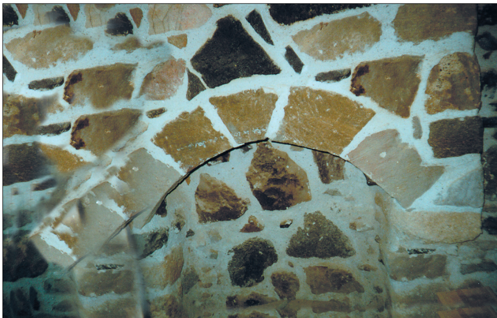
Πετρόχτιστη καμάρα τζακιού
