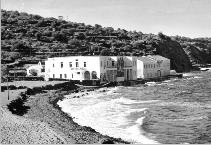
Η αριστοτερή πτέρυγα (Α' θέση) μετά την αντικατάσταση της κεραμοσκεπής από πλάκα από σκυρόδεμα
