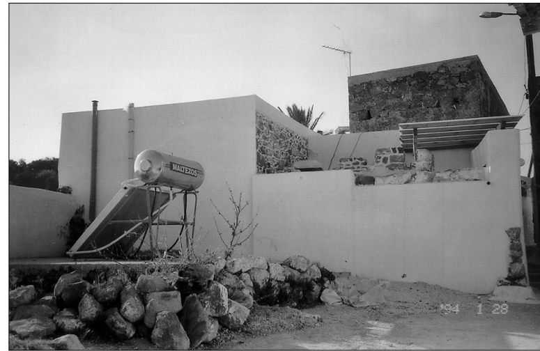
Επισκευαζόμενο σπίτι στον Εμπορειό.
