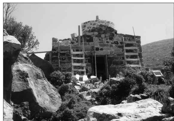
Η εκκλησία της Φανερωμένης στο στάδιο της αναστήλωσης.
